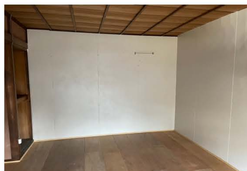
新しい個室となる空間（全三室）
